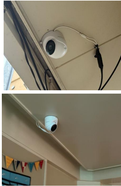
図3 Synology社製TC500型機 （園内に設置の様子 [筆者撮影、2025年]） （画像解像度 2880x1620, PoE:Power over Ethernet, Wi-Fi 接続）
