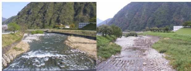
写真 2. 魚野川（大野原橋）の流量変化の様子
