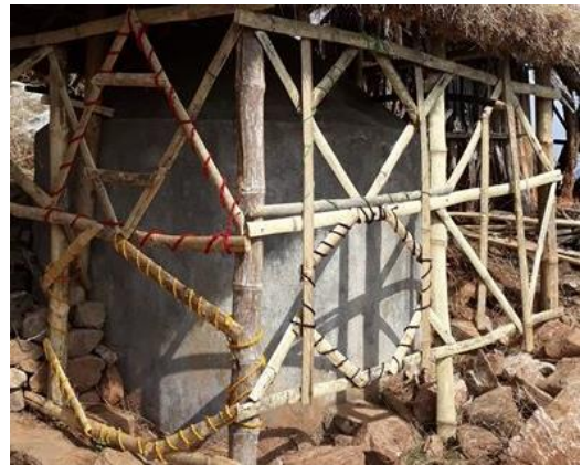
写真 1. 貯水タンクを覆う竹組みの小屋
